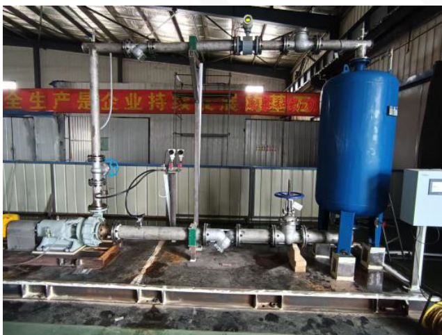
胶乳泵综合性能测试系统
