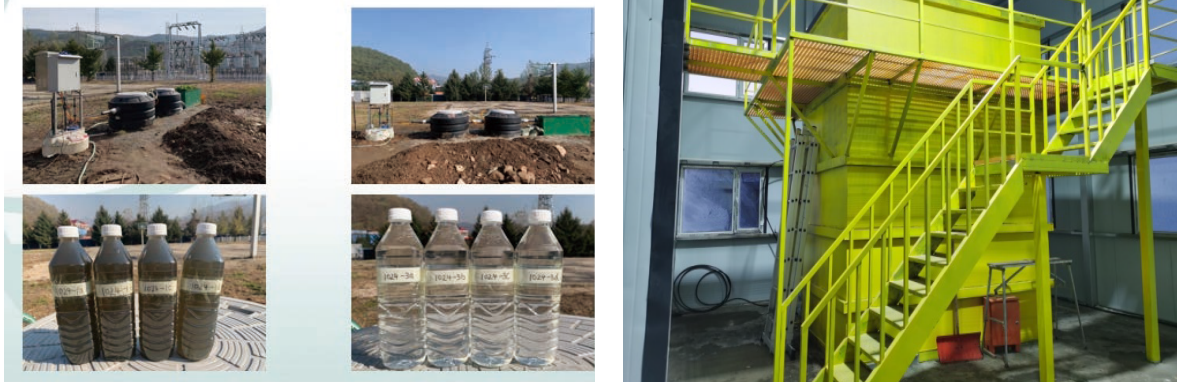
处理水量 20m 3 /d 的村镇分散式生活污水处理设备
